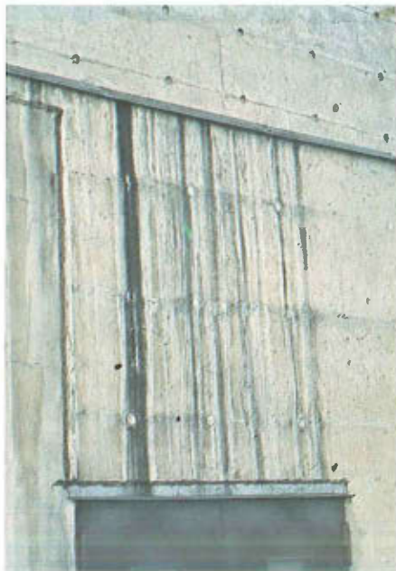
Utilstrækkelig vandafvisning (se næste side)
