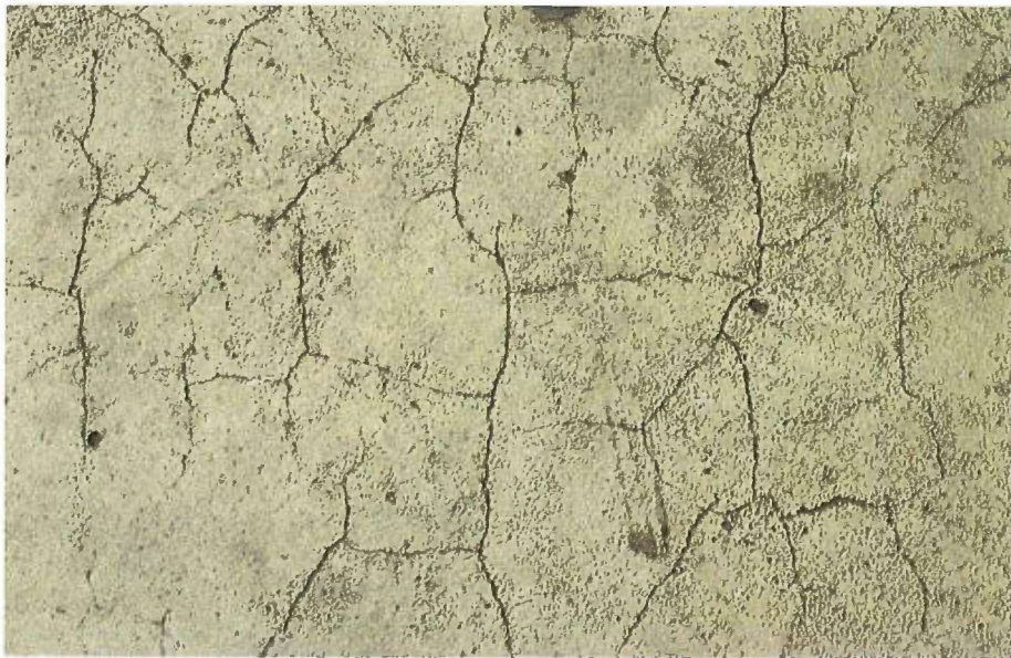
Typiske netrevner forårsaget af udtørring
