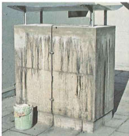
Utilstrækkelig vandafvisning (se næste side)
