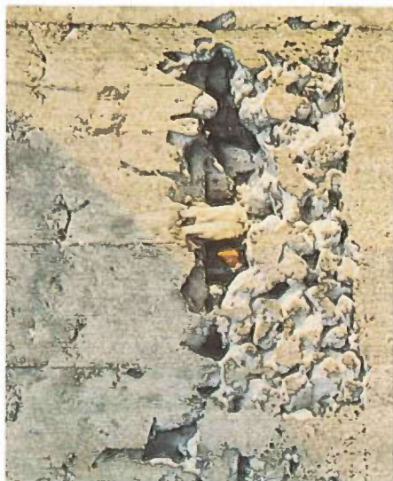
Vand til den forspændte armering – gennem revner og stenreder. (Foto 1958)
