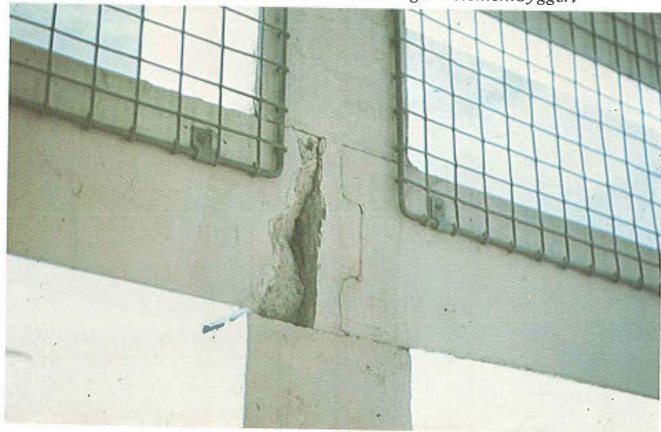
Facadeelementer med revnedannelse
