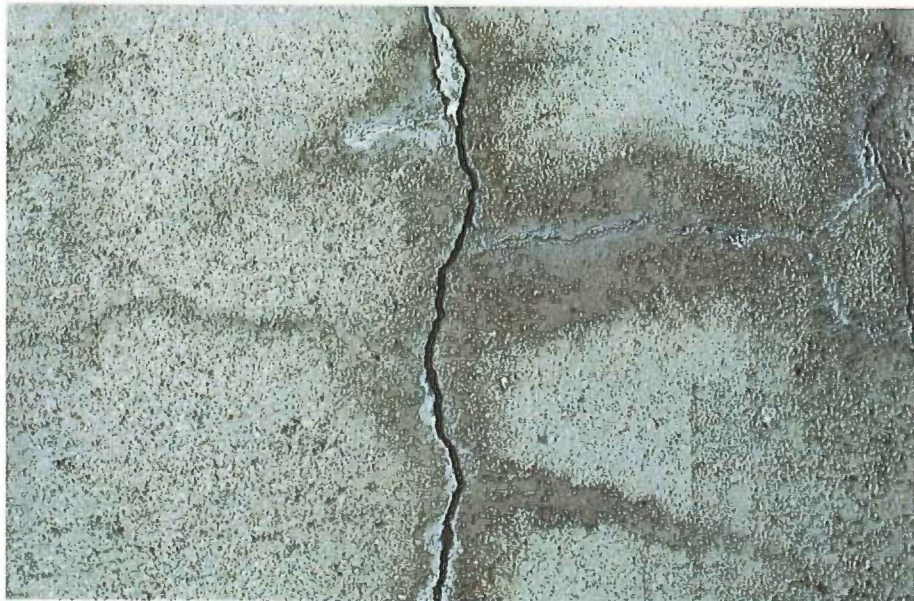
Ikke alle revner skyldes svind, her er det alkalikiselreaktion
