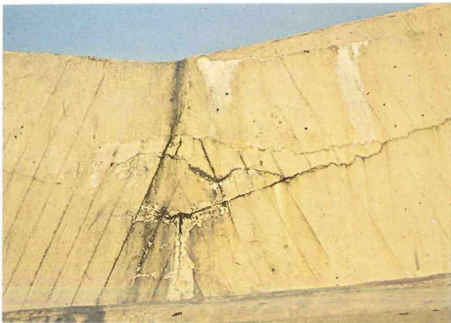
Vand til den forspændte armering – gennem revner og stenreder. (Foto 1958)
